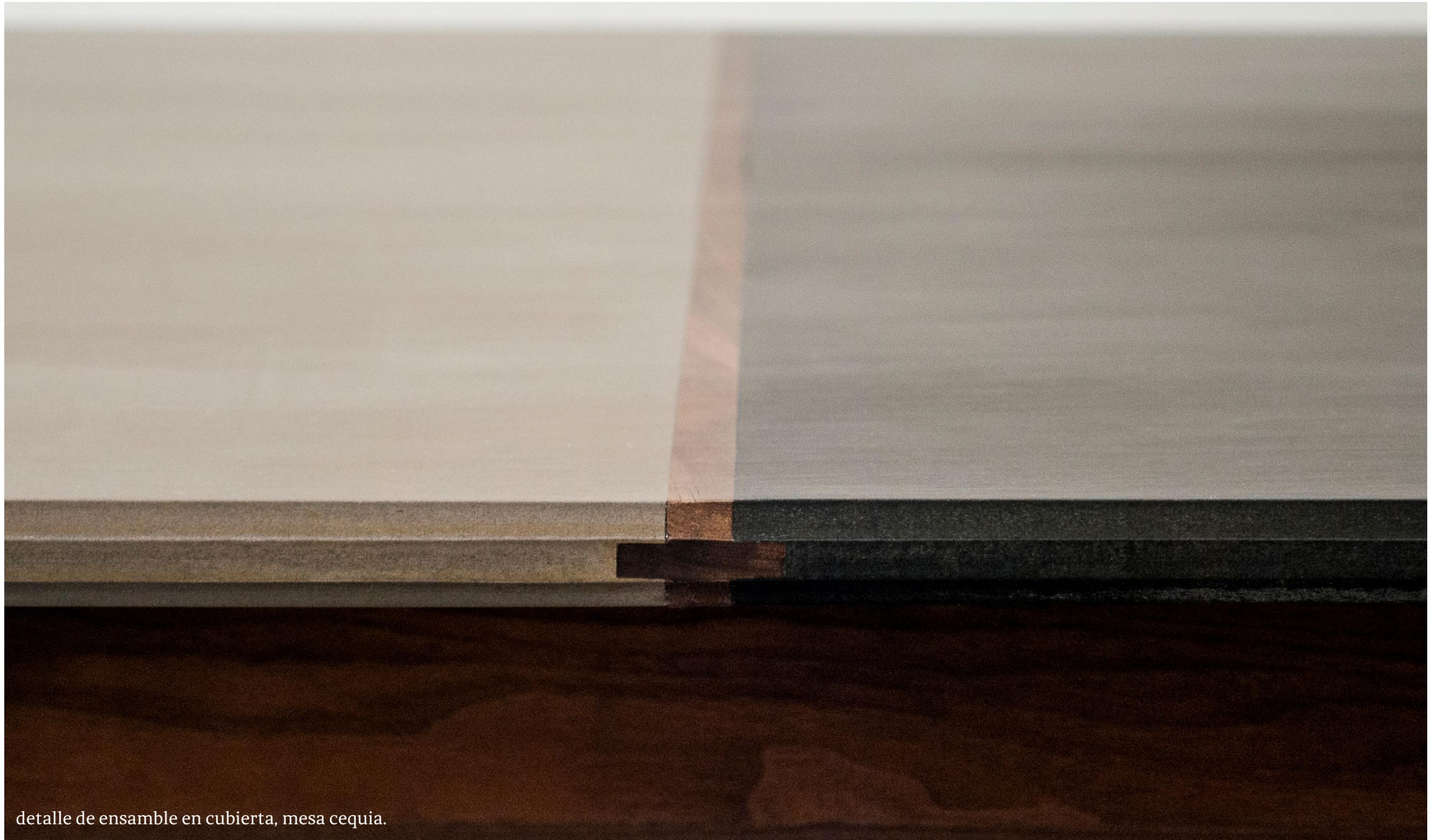
detalle de ensamble en cubierta, mesa cequia.
